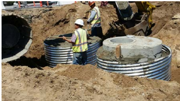
Slurry seal/backfill, DS 1E and 1T
