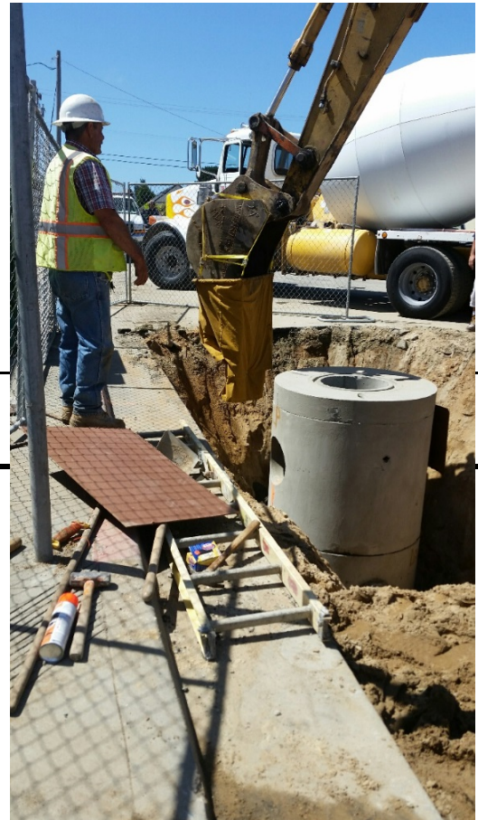
HDPE pipe slurry, DS 1P
