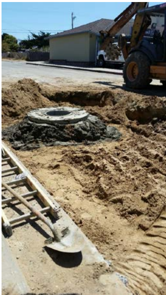
Slurry seal/backfill DS 1P
