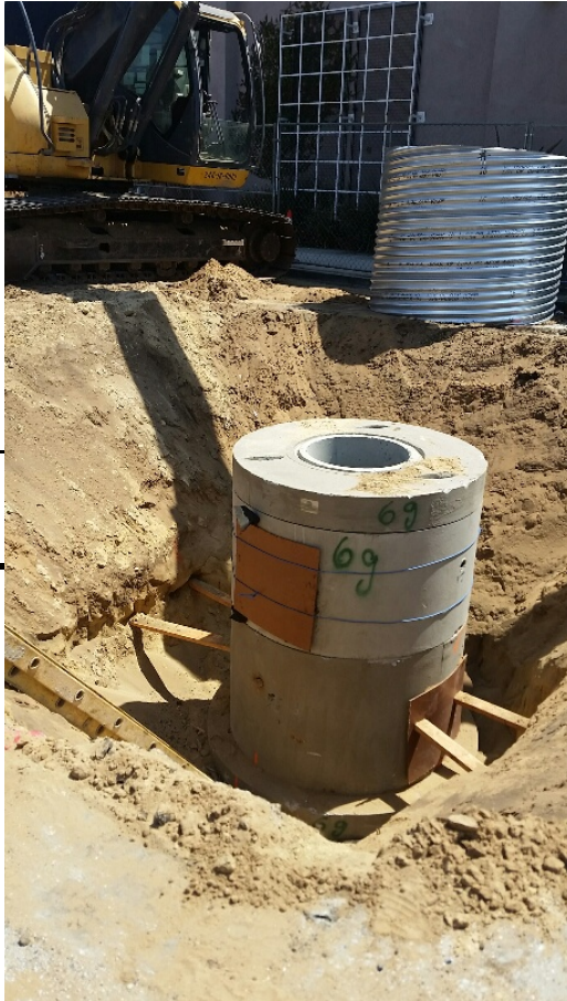
| | DS 6g manhole installation | | | |
